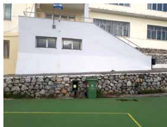
ΓΥΜΝΑΣΙΟ ΑΥΛΩΝΑΡΙΟΥ ΕΣΩΤΕΡΙΚΑ ΜΕΤΑ
