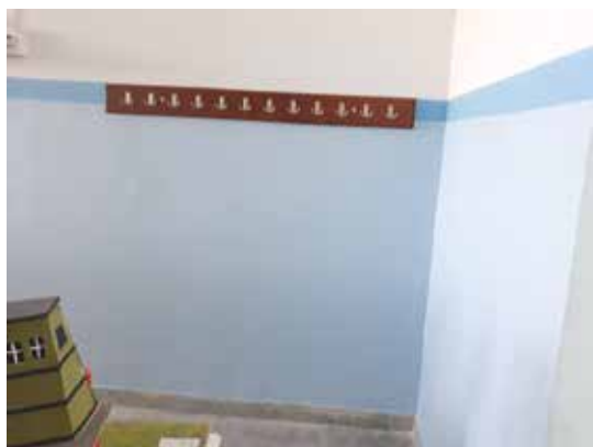
ΓΥΜΝΑΣΙΟ ΑΥΛΩΝΑΡΙΟΥ ΕΣΩΤΕΡΙΚΑ ΜΕΤΑ
