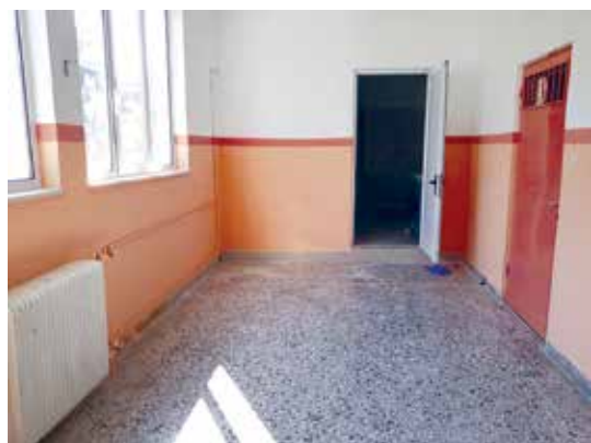
ΓΥΜΝΑΣΙΟ ΑΥΛΩΝΑΡΙΟΥ ΕΣΩΤΕΡΙΚΑ ΜΕΤΑ
