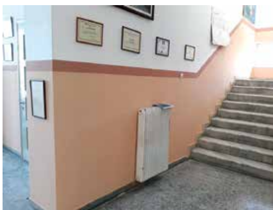
ΓΥΜΝΑΣΙΟ ΑΥΛΩΝΑΡΙΟΥ ΕΣΩΤΕΡΙΚΑ ΜΕΤΑ
